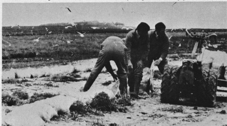
Het bouwen van de zandzakkendijk rondom de bedreigde grote sternkolonie
