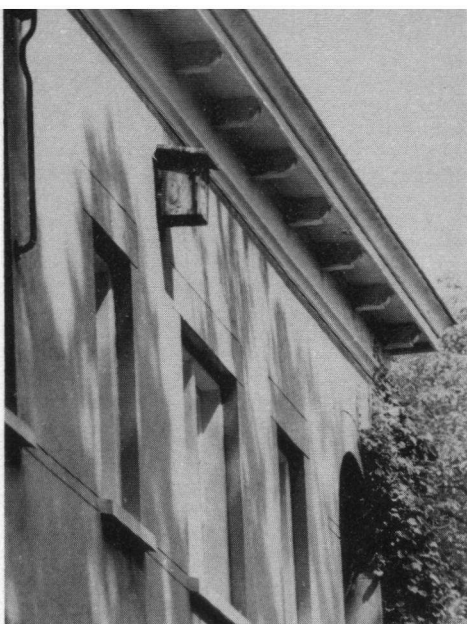
Spreuwenkast onder de dakrand, waarin Gierzwaluwen nestelden. Hilversum, 31 juli 1982. Foto: Jaap Taapken.
