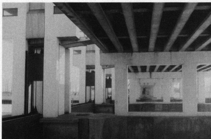
Nijkerkersluis, onderaanzicht van het bruggencomplex met links de heftoren, februari 1986. Foto: Rijkswaterstaat, Directie Zuiderzeewerken.
