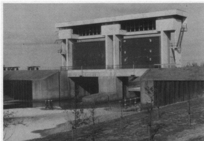
Hoge Knarsluis, geïsoleerd liggend object op de grens van Oostelijk en Zuidelijk Flevoland, februari 1986.
