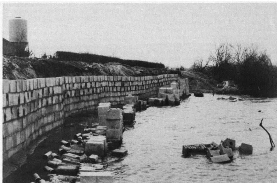
De oeverwaluwalenwand bij 'Het Hemelrijk' in aanbouw, februari 1986.
