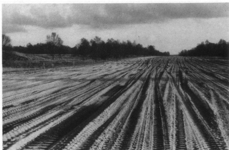
Zandtankbaan op lichtbeboste heide, Leusderheide, 7 februari 1988.
