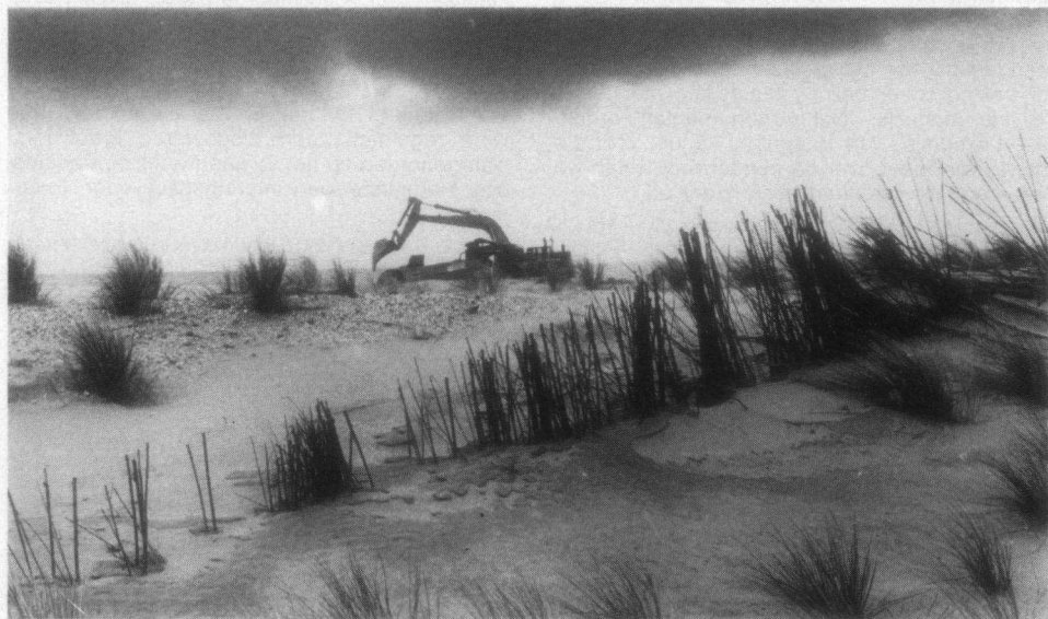
In het stuivende zand leggen bulldozers de grondslag voor nieuwe natuur op Neeltje Jans.
