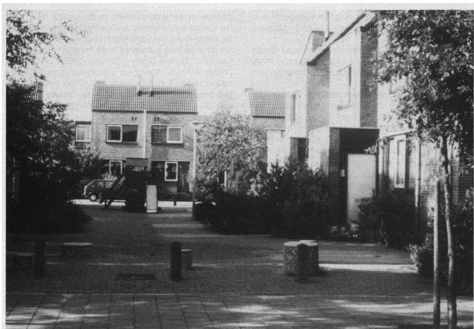
Inzicht in een der subonderdelen van de woonwijk Achtse Barrier. De schoorstenen zijn in dit (nog) vogelarme deel ongeschikt als broedplaats voor vogels.
