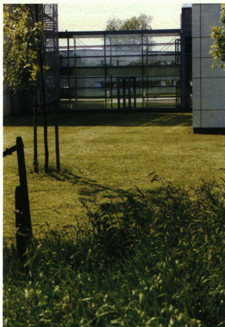
Reflecterend glas wordt soms aangezien voor een doorgang. Foto: J. Vochteloo.
