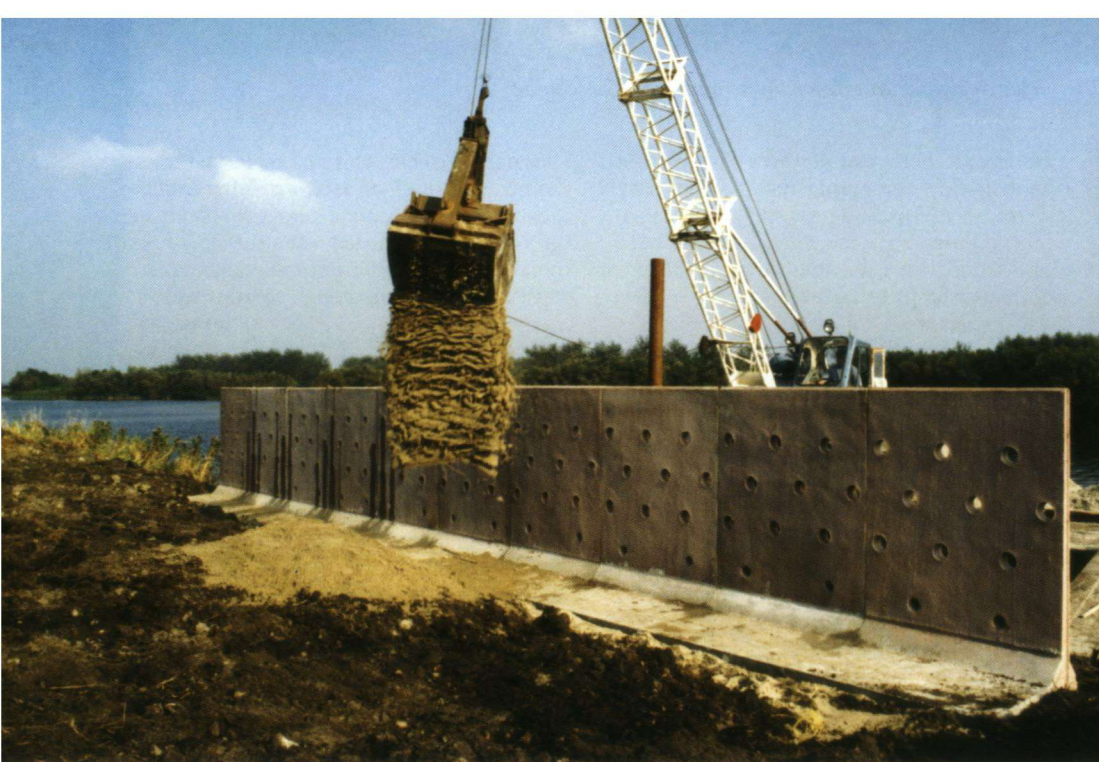
Aanleg van een breedwand voor Oeverwaluven in Het Twiske.
