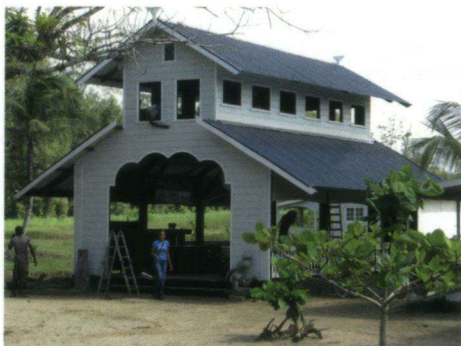
Kopie van de oude houtloods van plantage Kerkshoven aan de Warappakreek. In dit sfeervolle gebouw wordt op Bakkie het ontbijt en avondmaal door de gasten van Stichting Warappa genoten. Foto: Bas Spek.
