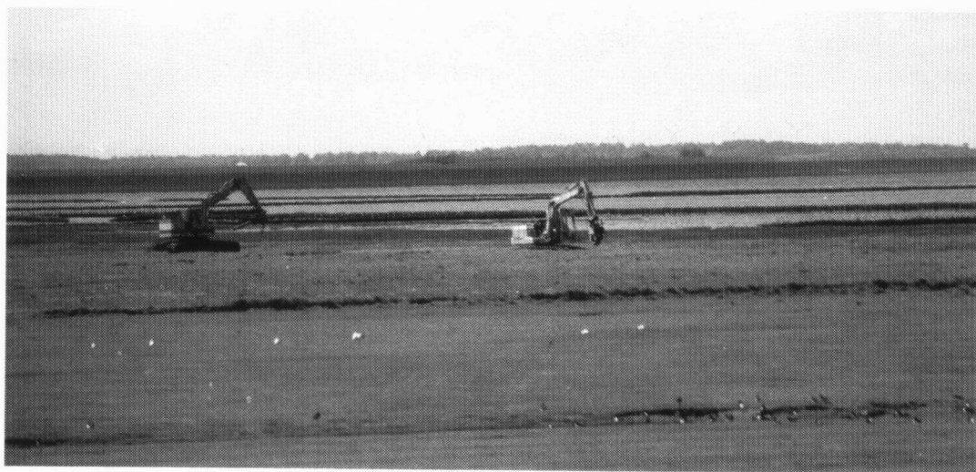
Graafwerkzaamheden op de kwelders van de West- en Julianapolder, april '00.
