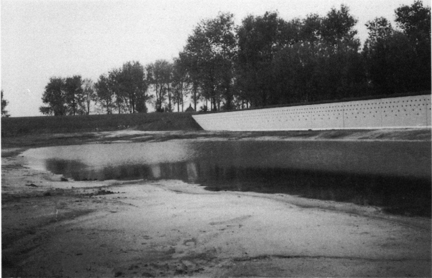
Foto. Overzicht van de oeverwaluwand te Meppel, direct na oplevering (E. Quené).
