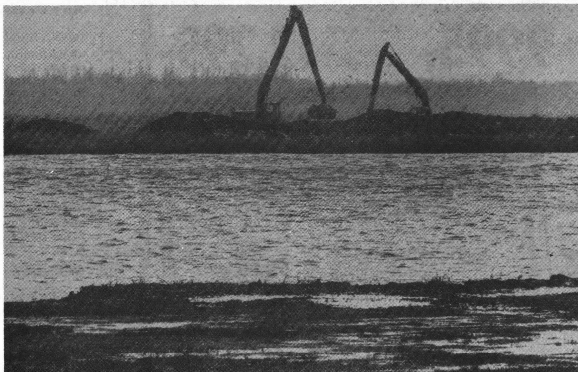
Draglines graven een nieuwe kade in de Binnemiede langs het Sierdswiel, maart 1993
