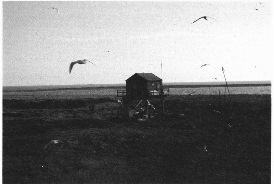
Bewakingshuisje op Griend
