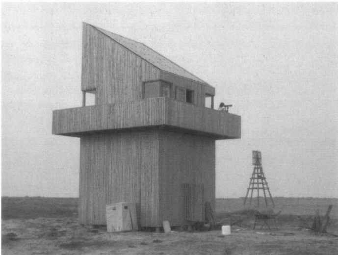
Het nieuwe vogelwachtershuis op Griend. foto: Date Lutterop
