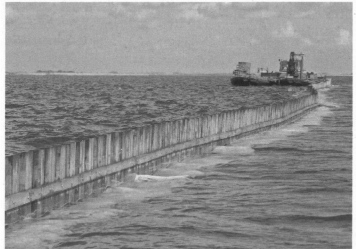
Aanleg van houten damwand in de Fluessen foto: Hans Pietersma
