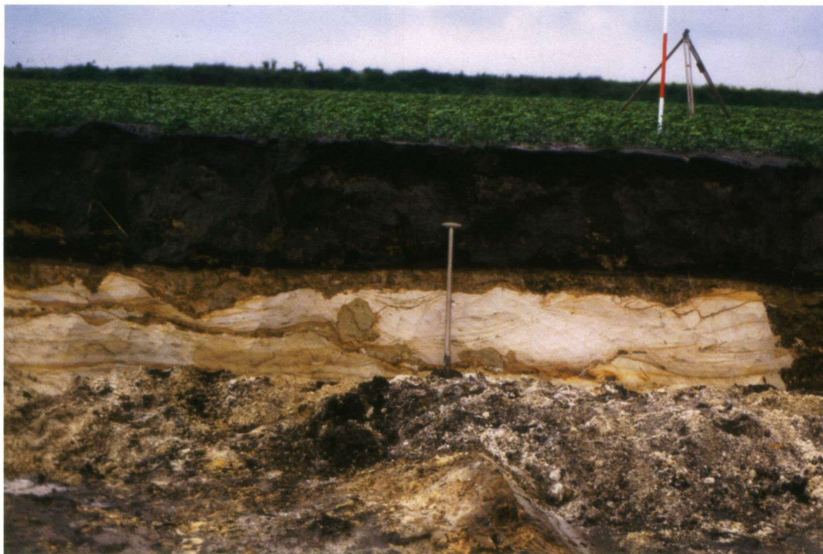
Afbeelding 6. Geulstructuren in de Formatie van Waalre (Tegelen) langs het Moleneind ten oos- ten van Ossendrecht. De dikke zwarte oude bouwlandlaag (esdek), die elders in Nederland meestal op dekzand is ont- staan, ligt hier direct op de Formatie van Waalre uit het Vroeg- Pleistoceen.
