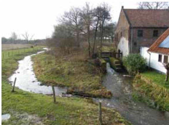
Figuur 1. Temporele migratiezone (links) bij Schouwsmolen te Ittervoort, op 18 april 2011 enkele maanden na de aanleg. Op de voorgrond is de lokstroom vanuit de TMZ zichtbaar. (Foto: Hans de Mars)
