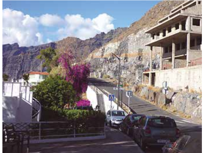
Foto 17: Appartementen in aanbouw met daarachter aan de weg de vindplaats van zeolieten bij Los Gigantes.
