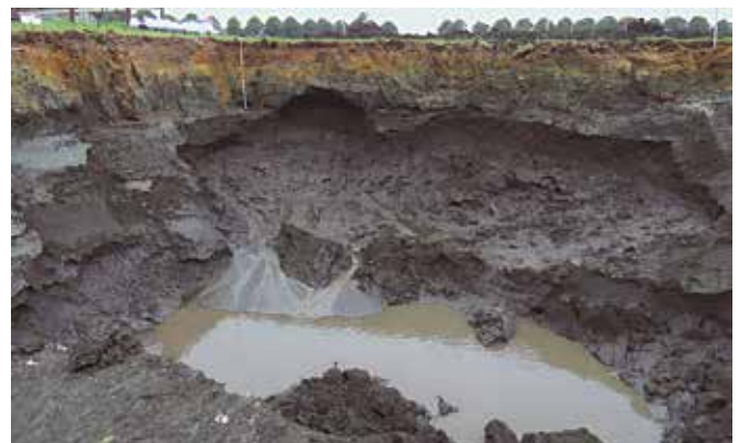
Afb. 2. Onderin de put vormt zich een plas grondwater.
