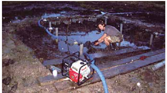
Afb. 9. Eerste pomptest in de dodopolder door Perry de Louw, die aantoonde dat de damwanden voldoende waterdicht zijn (aanleg dodopolder, 2007).
