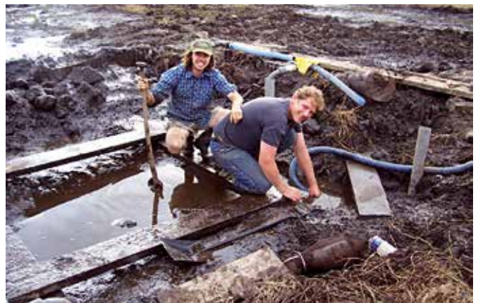
Afb. 8. Dodopolder gereed, pompen worden aangesloten (aanleg dodopolder, 2007). Links Perry de Louw, rechts René Floore.
