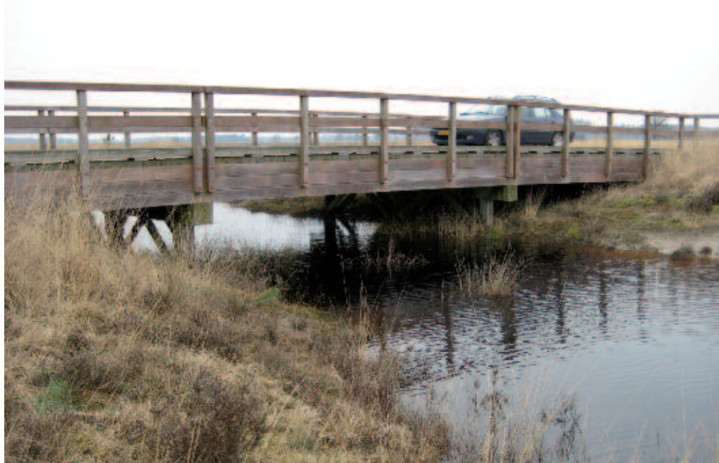
Een brugconstructie over een speciaal aangelegde slenk in het Drents Friese Wold; een creatieve oplossing voor duurzame ontsnippering. In 2010 zijn hier vier Ringslangen waargenomen die er gebruik van maakten (foto: R.P.J.H. Struijk).
