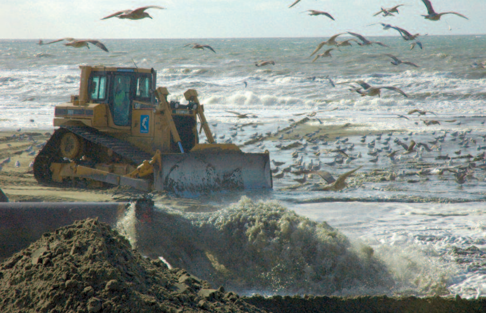
Foto 1. Bij een strandsuppletie wordt met bulldozers het opgespoten zand over het strand verdeeld (foto: Martin Baptist, IMARES).
