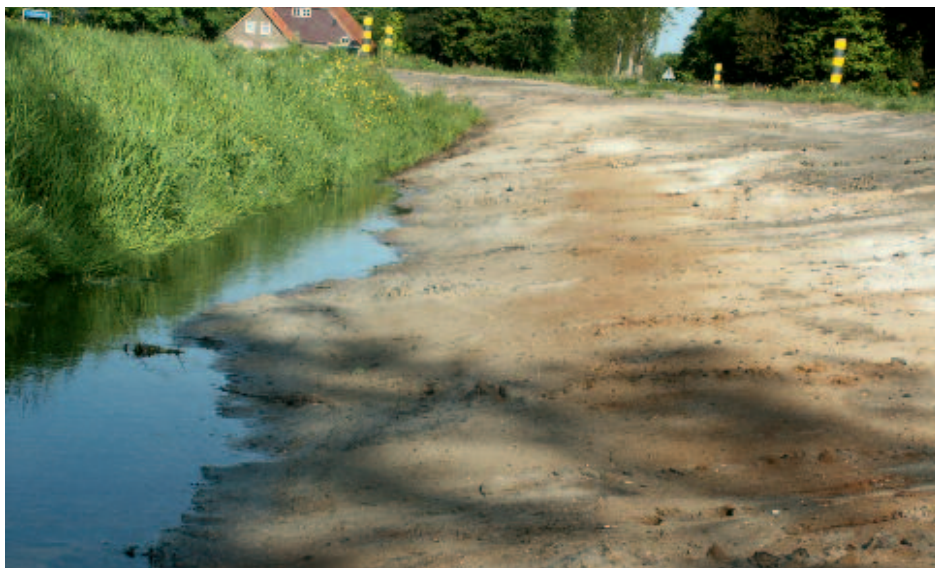
Foto 2. Op enkele locaties is tot op de slootbodem geplagd.
