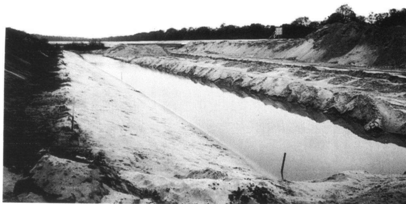
Zanderij Crailo, gezien in noordelijke richting: werk in uitvoering
