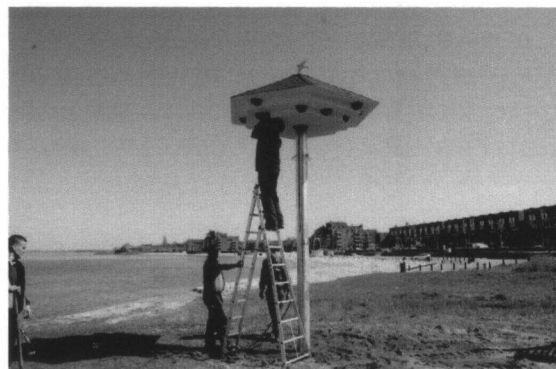
Bouw van de zwaluwtil bij Huizen
