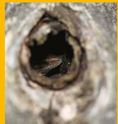
Een levendbarende hagedis in een rottingsholte in een schoorpaal.
