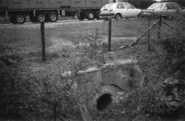
In het tracé zullen 16 dassentunnels worden aangelegd.
