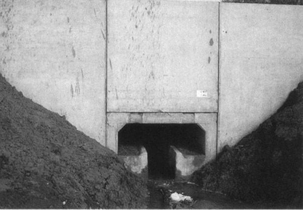
Schema van een duiker met droge oevers voor de passage door dieren.
