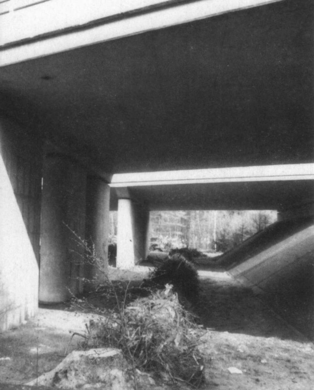
De doorgaande stobbenwal onder het viaduct, tijdens de aanleg. Foto Fos Oude Elferich
