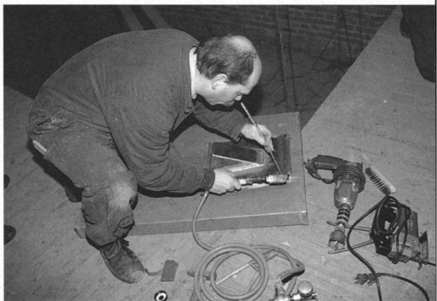
Om de mest van een grote groep vleermuizen op te vangen is op de zolder van de kerk van Oud-Valkenburg een vlonder gemaakt. Foto Ludy Verheggen
