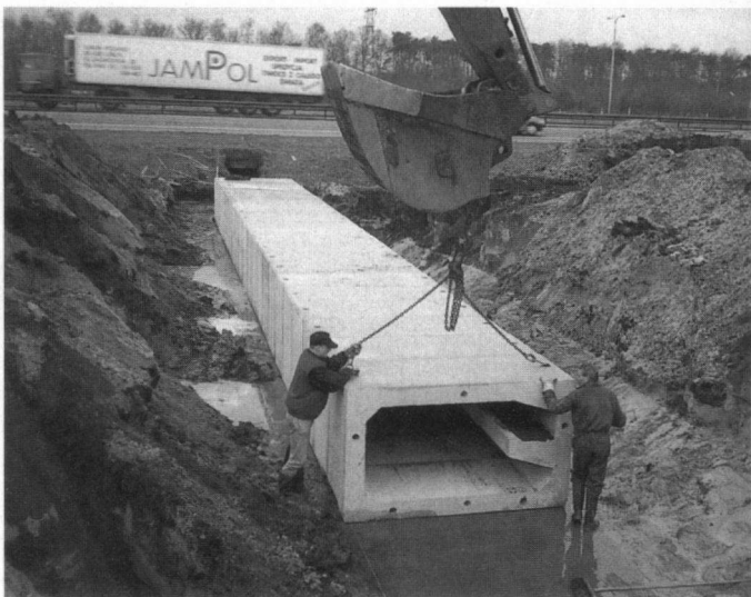
Faunapassage in aanleg. Foto Peter Petter
