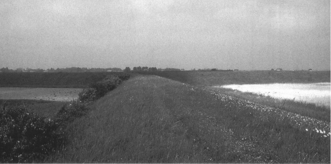
Dijk langs de Preekhilpolder op Goeree. In het riet aan de ene kant leven noordse woelmuizen, in het gras aan de andere kant veldmuizen. Foto Floor van der Vliet
