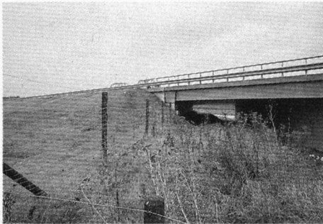
fig. 9. Wilduitwisseling is onder deze snelweg (bij Postojna, Joegoslavië) geen probleem. fig. 10. Wildtunnel in Frankrijk, die wel door Ree en Vos, maar niet door Edelherten wordt gebruikt. fig. 11. Brug over de Schipbeek, die tevens als 'wild-tunnel' dienst doet.
