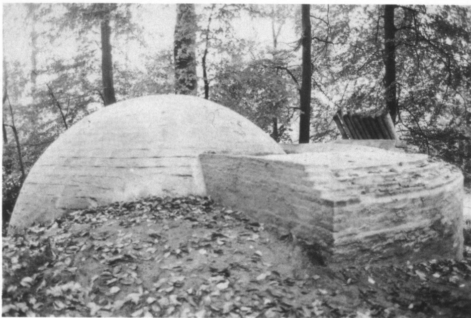
foto onder: De nog niet met zand afgedekte ijskelder, die geheel is gerestaureerd. Landgoed 'Schaep en Burgh', 's-Graveland, 23 september 1984. Foto's: Jaap Taapken.
