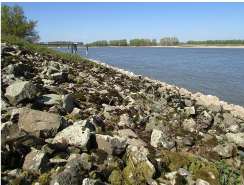
Figuur 1. Oeverbeschoeiing aan de Rijn bij Kekerdom in de Millingerwaard. Foto: Henk Greven.
