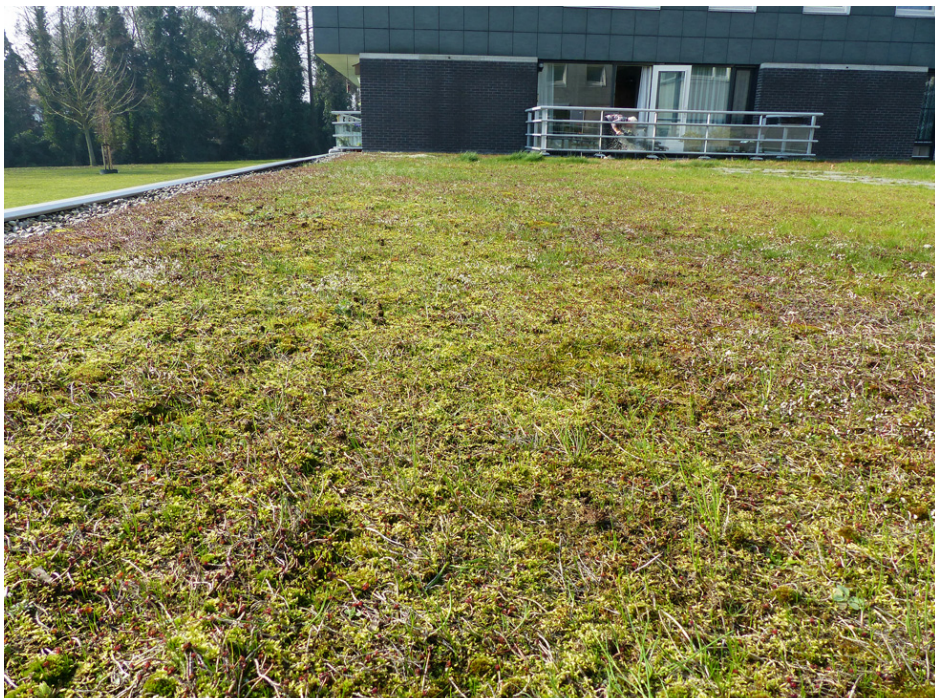
Figuur 3. Mosrijk Sedum -dak aan de Coldstream in Thiemsland, Hengelo (Ov.).
