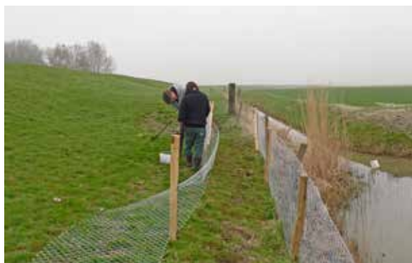
Aanleg van een struweeltje langs de zuidzijde van de Middendijk bij Den Andel, voorjaar 2013. Foto: Evert Mulder
