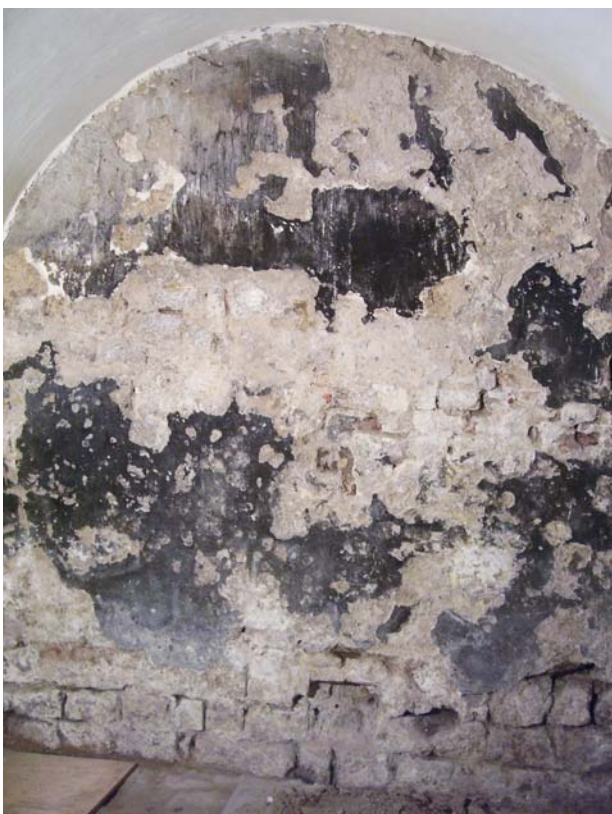
AFBEELDING 4. | Romeins muurwerk uit Römer tuf onder Domplein 4 in Utrecht (voor de herinrichting). De foto links toont een stuk muur waarvan het onderste, regelmatige deel oorspronkelijk Romeins metselwerk is en het hogere, onregelmatig en deels van afwerking voorziene deel later opnieuw is opgetrokken met secundair materiaal. De rechter foto toont een doorsnede van het muurwerk.
