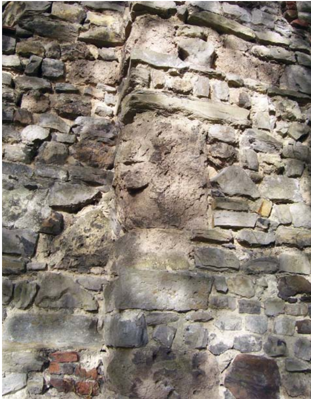
AFBEELDING 10. | Römer tuf in Vlaanderen: links een groot, secundair gebruikt blok aan het restant van de 10e-eeuwse muur van de Sint Baafs abdij in Gent, rechts in het parement (samen met restauratie-Ettringer tuf) van de 13e-eeuwse Onze Lieve Vrouwe kerk in Damme. Foto: G.J.L.M. de Haas.
