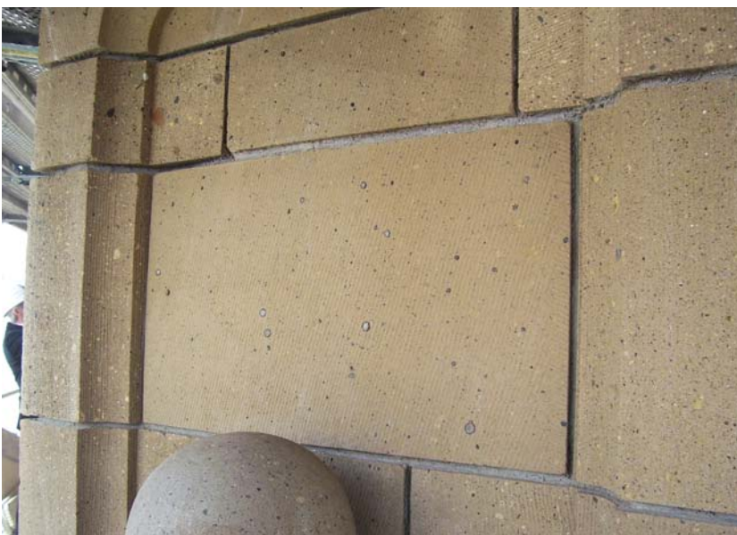
AFBEELDING 13. | Net geplaatste Weiberner tufsteen aan de Laurenstoren in Rotterdam uit 2011.
