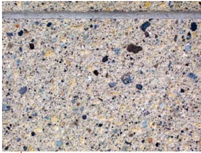
AFBEELDING 14. | Ettringer tufsteen aan de sokkel van het Willibrord standbeeld in Utrecht.
