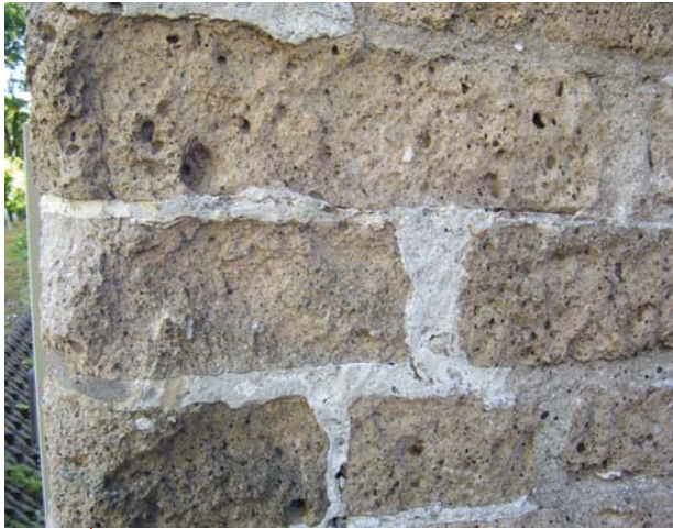
AFBEELDING 5. | Karakteristiek voorbeeld van Römer tuf, links aan de Sint Pancras in Castricum, rechts aan de Pandhof van Sinte Marie in Utrecht.
