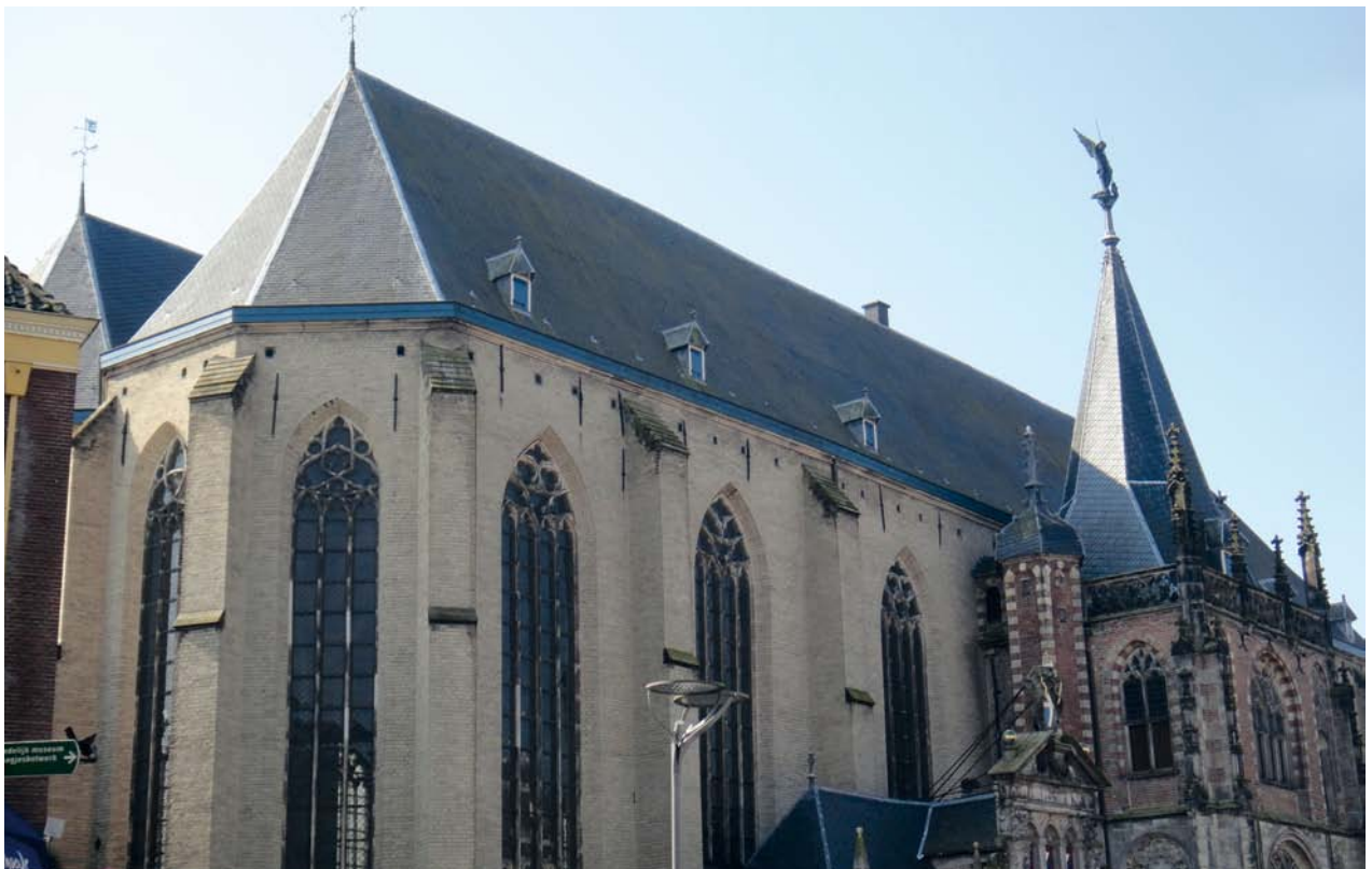
AFBEELDING 15. | De Grote of Sint Michaëlskerk in Zwolle uit 1406-1466. Het parement bestaat grotendeels uit Weiberner tuf.
