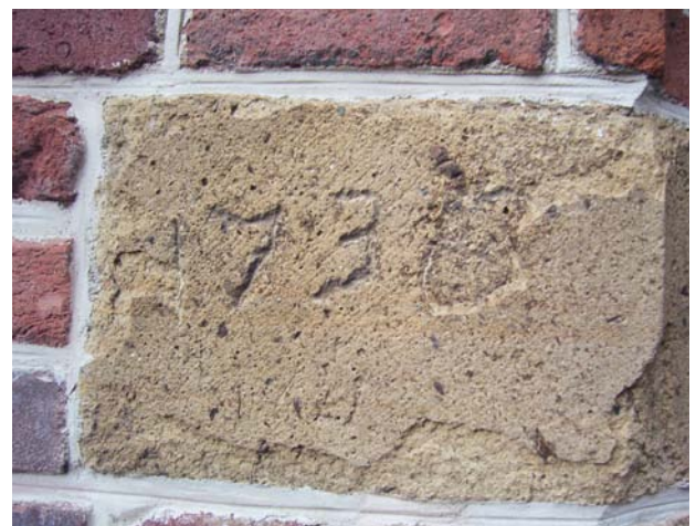
AFBEELDING 11. | Laacher tuf uit de 18e eeuw aan de viering van de Sint Janskathedraal te 's-Hertogenbosch. De linker foto geeft een overzicht, waarin de oranje blokken Laacher tuf zijn en de beige blokken in de ronding van de blindnissen Römer tuf; rechts een detail van een blok Laacher tuf uit de jaren 1730.
