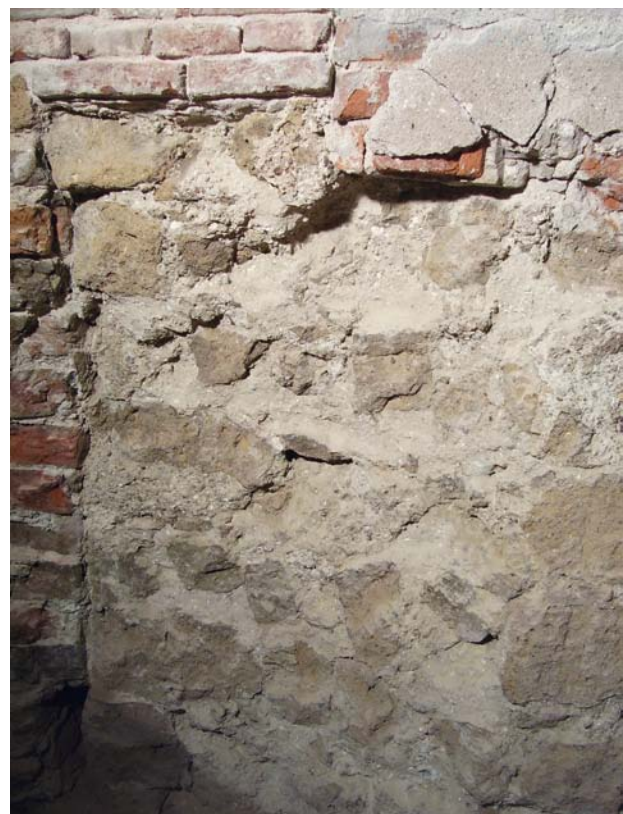
AFBEELDING 4. | Romeins muurwerk uit Römer tuf onder Domplein 4 in Utrecht (voor de herinrichting). De foto links toont een stuk muur waarvan het onderste, regelmatige deel oorspronkelijk Romeins metselwerk is en het hogere, onregelmatig en deels van afwerking voorziene deel later opnieuw is opgetrokken met secundair materiaal. De rechter foto toont een doorsnede van het muurwerk.
