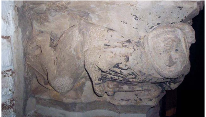
AFBEELDING 16. | Kraagsteen uit 1425 in de Pieterskerk in Leiden uit Weiberner tuf.
