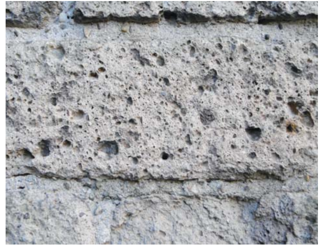
AFBEELDING 5. | Karakteristiek voorbeeld van Römer tuf, links aan de Sint Pancras in Castricum, rechts aan de Pandhof van Sinte Marie in Utrecht.
