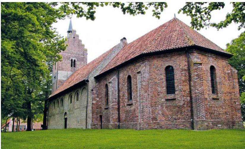
AFBEELDING 2. | De Magnuskerk in Anloo is een van de Drentse 'oerkerken'. De muren van het schip zijn opgetrokken uit Römer tufsteen uit de Eifel. Het zwerfsteengebruik beperkte zich bij de bouw uitsluitend tot ondiep ingegraven en niet zichtbare fundamentstroken.
