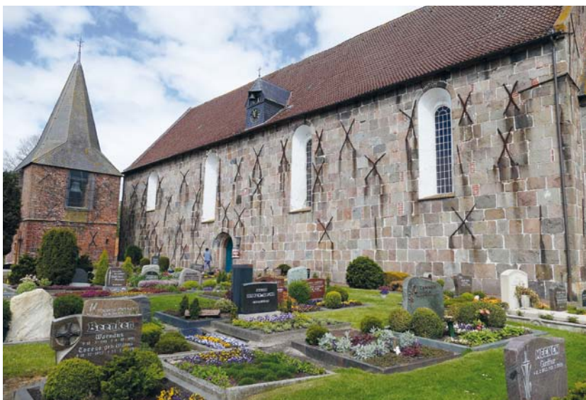
AFBEELDING 17. | Zwerfsteenerkerk van Tettens, zuidelijk van Hohenkirchen in Ostfriesland. De uit zware bouwblokken opgetrokken kerkmuren zijn minder stabiel als men zou verwachten. Dat komt vooral omdat de gebruikte schelpkalk niet erg goed aan de harde zwerfstenen hecht. Door werking van de muren was men genoodzaakt om zware ijzeren muurankers toe te passen.
