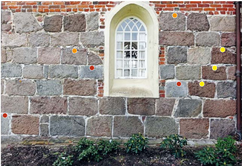
AFBEELDING 8. | Noordmuur van het koor van de Margarethakerk in Odoorn. De stippen op de stenen in de muur maken duidelijk dat middeleeuwse stenhouders meermalen uit grote zwerfblokken twee of meer bouwblokken wisten te splijten. De gele zijn van Ålandrapakivi, de rode zijn van grijze, ruw bekapte zandsteen. De oranje stippen markeren drie van de vier toegepaste bouwblokken van Bornholmgraniet (Hammergraniet).
