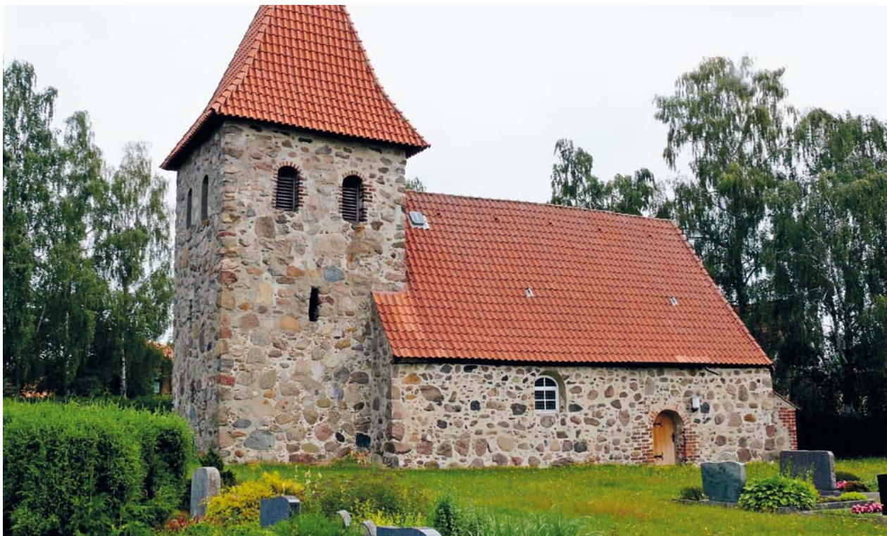
AFBEELDING 13. | Zwerfsteinkerke van Nienbergen in het Wendland, ten zuiden van Lüchow. Dit is een van de meest gave 'Feldsteinkirche' in het Wendland. Zowel de toren als het schip zijn opgebouwd uit grote en kleinere zwerfstenen, die voornamelijk aan de zichtzijde met de beitel grof zijn afgevlakt.
