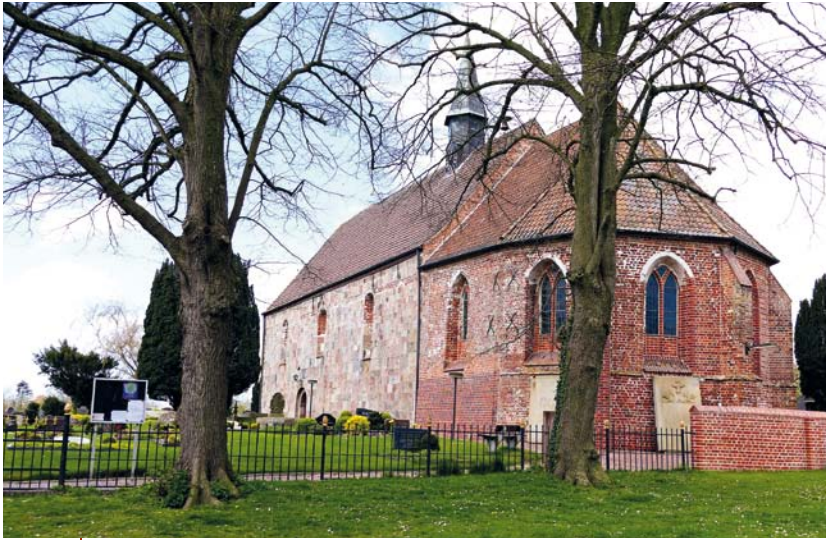
AFBEELDING 10. | De evangelisch-lutherse kerk van Wiarden in het noordoosten van Ostfriesland. Het opvallende schip van de kerk bestaat geheel uit vlak gekapte en gekantrechte bouwblokken, die men in de middeleeuwen uit zwerfstenen splete. Zwerfsteenkerken als deze komen op de wierden in het kleigebied van Ostfriesland veel voor.
