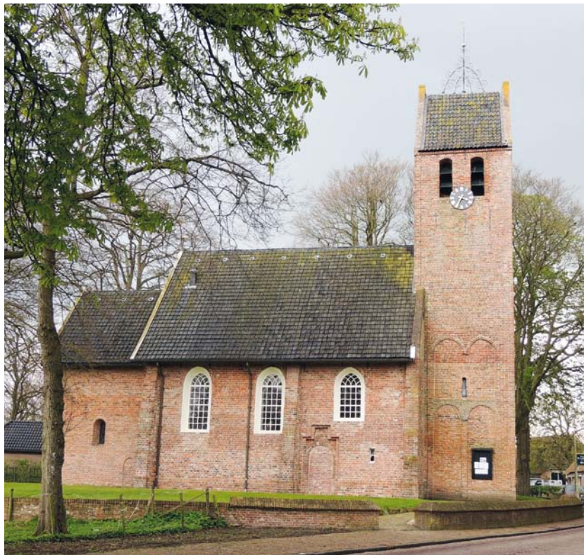
AFBEELDING 9. | De bakstenen Bartholomeuskerk van Noordlaren. Zwerfstenen werden uitsluitend verwerkt in fundamentstroken onder toren en kerk. De dikke kerkmuren bestaan uit kistwerk, met een muurvulling van zwerfkei'tjes, baksteenafval en schelpkalk.
