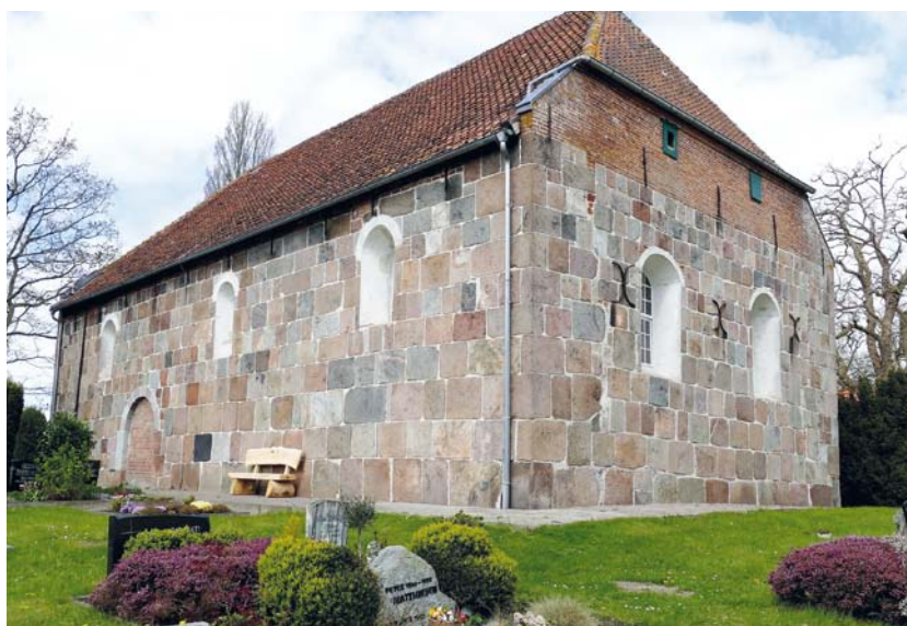
AFBEELDING 14. | Aan de muren van de kerk van Asel, iets oostelijk van Wittmund, is duidelijk te zien dat de afgespleten bouwblokken door steenhouwers met hamer en beitel werden afgevlakt en zeer nauwkeurig op maat werden gekantrecht. De stenen zijn in regelmatige rijen boven elkaar gemetseld. Ondanks de massieve indruk, waren deze zwerfsteenmuren niet bijzonder stabiel.
