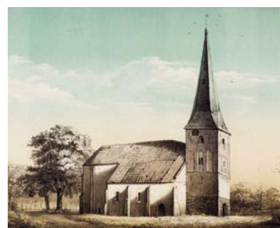
AFBEELDING 4. | Een oude tekening van de middeleeuwse Sint Pancratiuskerk in Emmen. De romaanse toren met zijn onderbouw van grote, gekantrechte zwerfsteenblokken ('hunebedbrokken') dateert uit de 12e of 13e eeuw. Het schip van de kerk is in de 19e eeuw afgebroken en vervangen door de huidige kerk.
