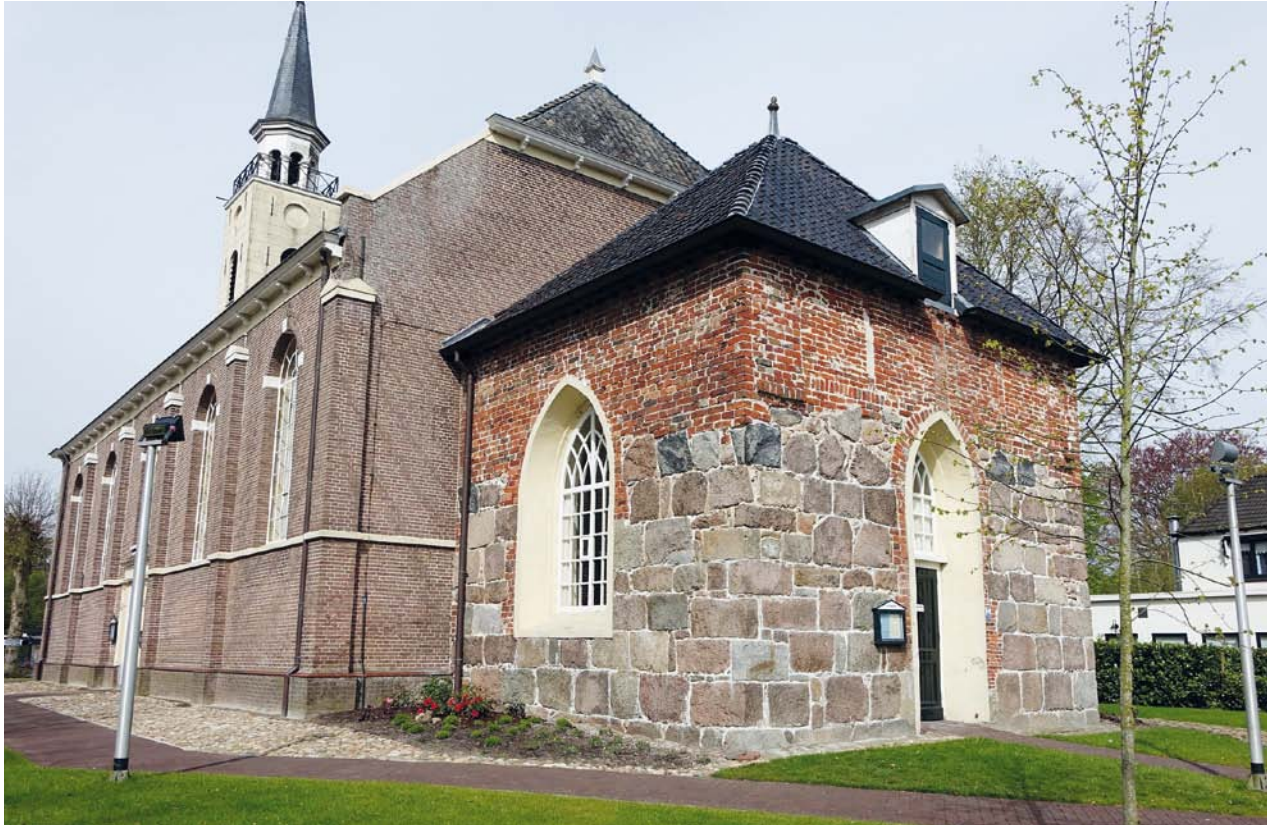
AFBEELDING 5. | De Margarethakerk in Odoorn met aan de achterzijde het smalle rechthoekige koor, dat grotendeels uit bekapte zwerfkeien is opgetrokken. De huidige kerk met toren dateert uit 1899. De nieuwe kerk werd gebouwd op de muurresten en fundamente van vorige kerk. De gebruikte zwerfsteenblokken zijn vergeleken met die in de kerken in Oostfriesland slechts ruw bewerkt.
