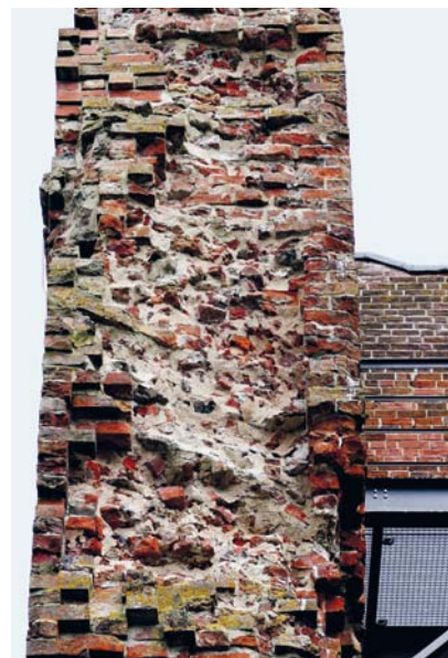
AFBEELDING 16. | Aan de dikke muren van de toren in Reepsholt is goed te zien dat men deze in kistwerk-techniek heeft opgemetseld.
