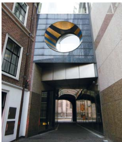
AFBEELDING 6. | Larvikiet aan het gebouw van de Tweede Kamer. Foto: T. Nijland.
