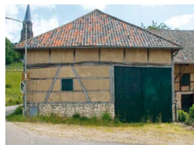
AFBEELDING 6. | Het Panhuiscomplex in Vijlen, opgetrokken uit Gulpener kalksteen. Foto: J.W. Stroucken.
