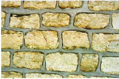
AFBEELDING 11. | Detail van muurwerk in Kunradersteen. Foto: J.W. Stroucken.
