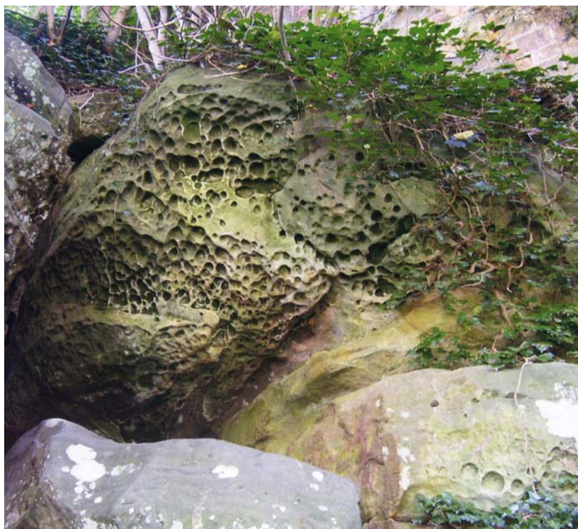
AFBEELDING 7. | De pokdalige vertering van Bentheimer zandsteen (Wabenverwitterung of alveoli) onder Slot Bad Bentheim.
