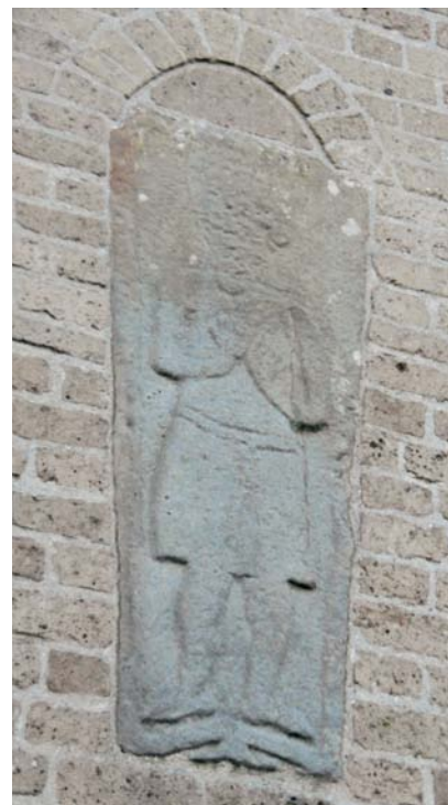
AFBEELDING 13. | Bentheimer zandsteen sarcofaagdeksel ingemetseld in het parement uit Römer tuf aan het schip van de Magnuskerk in Anloo.
