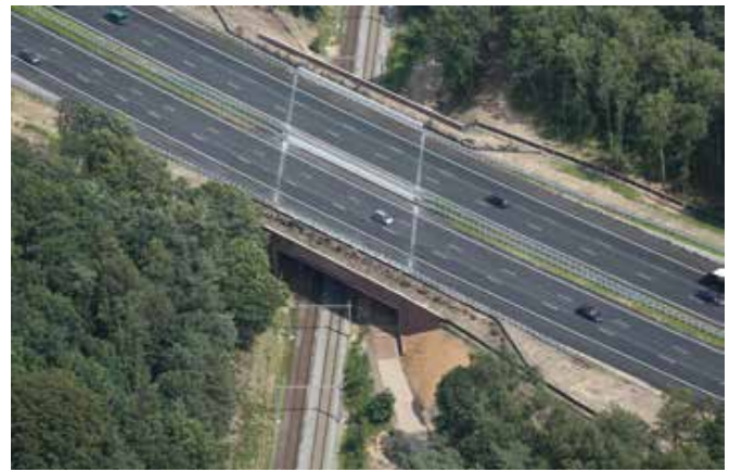
De bijzondere faunapassage bovenlangs het spoor, op twee stroken langs de rijbaan. (Foto: Heijmans)
