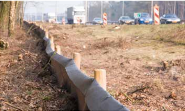
Scherf om reptielen uit het wegvanggebied te houden. Let op de plaatsing van de paaltjes en overstekende flap; deze voorkomen het inklimmen van dieren maar vergemakkelijken het uitklimmen. (Foto: Etienne de Vries)
