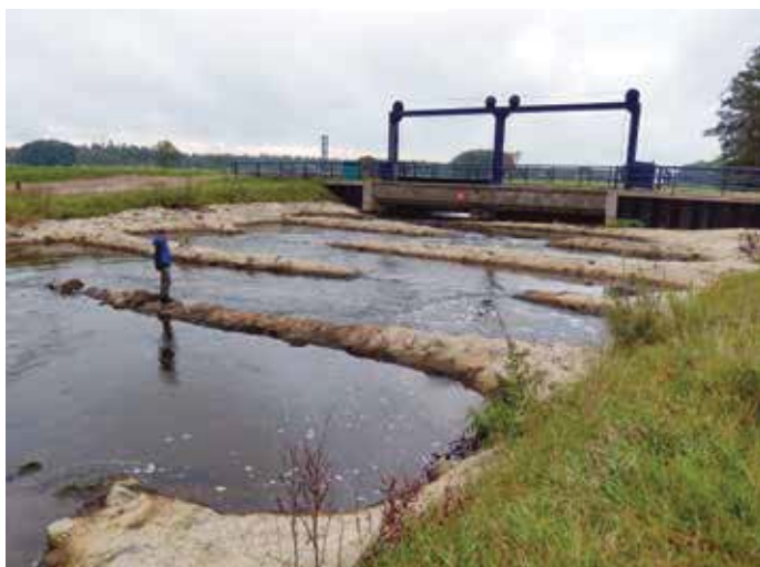
Vistrap bij stuw Warken, wat stenig uitgevoerd vanwege de dichtbij gelegen spoorlijn.
