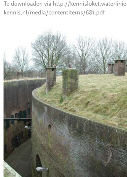
Dak van fort Honswijk.
