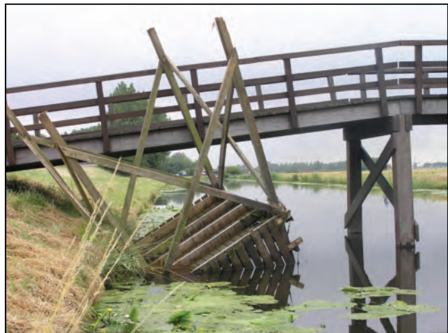
Vogeltoren in het water bij de fietsbrug over de Maandagse Wetering . (foto's: J. Jacobs)
