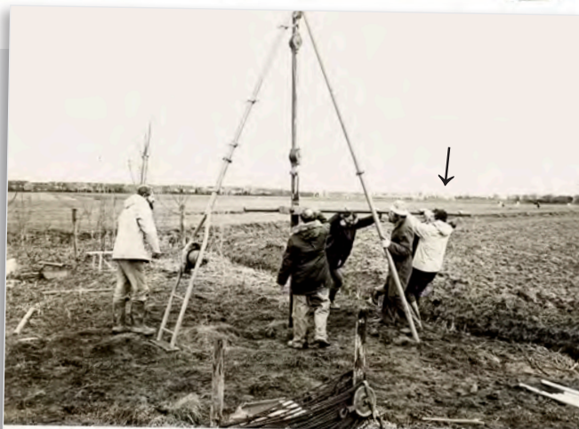
Anton in actie bij boring Zuurland in het begin van de jaren tachtig.
