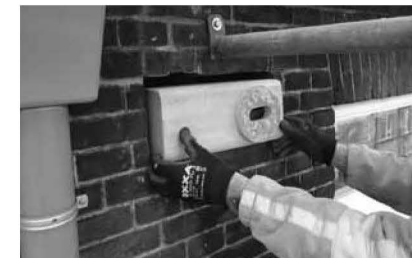
Het plaatsen van een beugelkast
