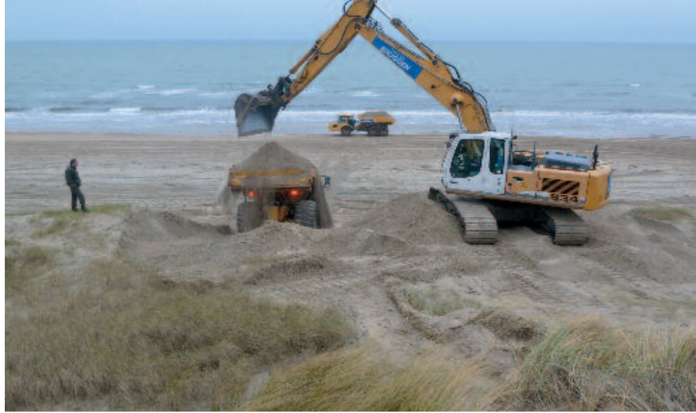
In de winter van 2012 op 2013 zijn de vijf sleuven gegraven. Er is 120.000 m 3 uit vrij gekomen dat is gebruikt om het Cremermeer te verondiepen en om het strand bij Zandvoort te verbreden. Voor het laatste reden de dumpers af en aan over het strand (foto: Coen van Oosterom).
